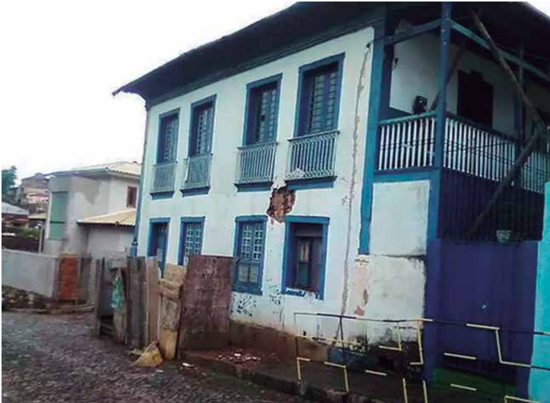
Patrimônio cultural, casarão que abriga escola corre risco de desabar, em Minas Gerais.
